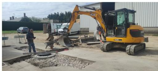
Réalisation de deux puisards afin de drainer les eaux pluviales. Le réseau préexistant était inefficace, responsable d'important écoulement dans des propriétés privées.
