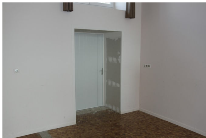
Porte d'accès au local située dans la salle des fêtes
