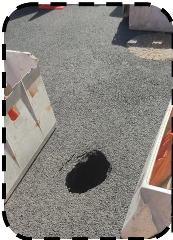
La circulation a été coupée pendant quatre semaines dans le bourg, suite à un effondrement de chaussée consécutif à une fuite ancienne sur une canalisation de petit débit. Au fil du temps la sous couche de l'enrobé a été ravinée de façon insidieuse, avant que la chaussée ne cède.
